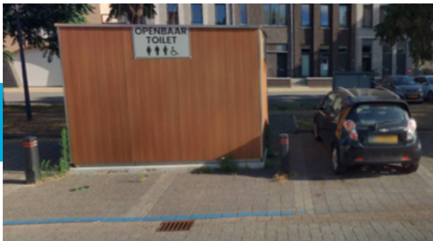
Oude situatie openbaar toilet
